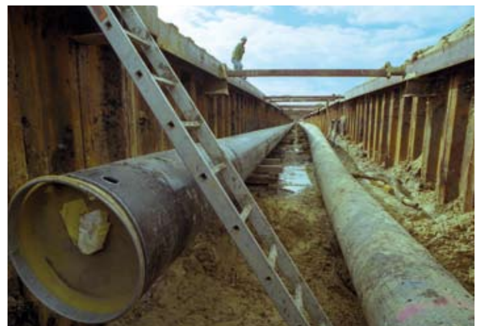
Verlegung einer Rohrfernleitung in Norddeutschland
