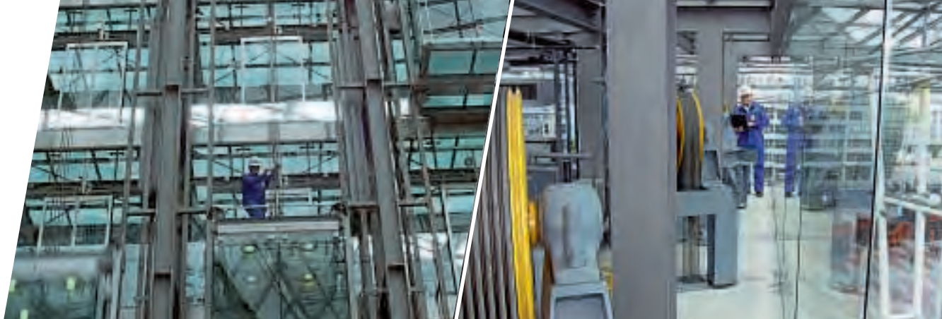
Wiederkehrende Prüfungen an Aufzügen durch unabhängige Dritte steigern die Sicherheit erheblich.
