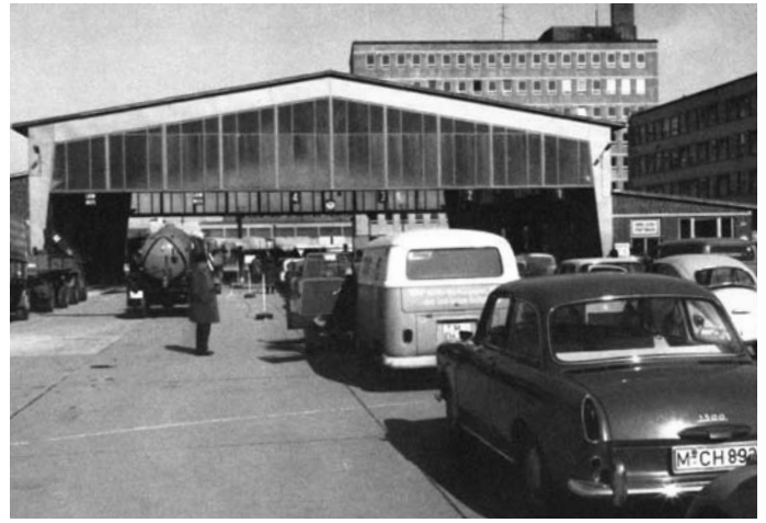
Großer Ansturm auf eine Prüfstelle in den 70ern.
