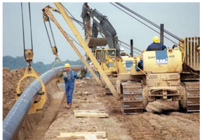
Verlegung der Erdgastrasse Schwerin-Rostock
